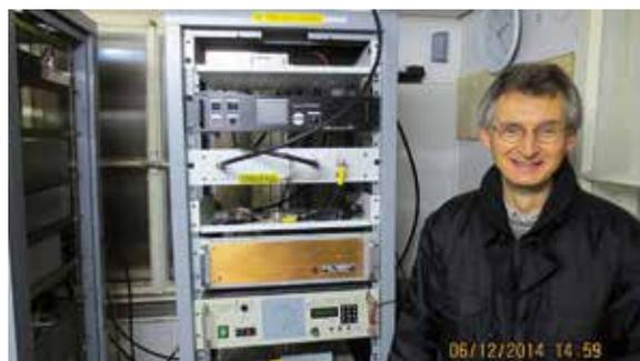
Alles komplett: Nach 2 Std. (UTC) Arbeit war DBØTRS wieder erreichbar. Oben die neuen Netzteil für DMR und C4FM. Darunter der C4FM Baustein, die Weiche/Duplexer und ein 19" Fachboden mit dem Zirkulator samt Dummy auf Kühlkörper. Hans, DL8MCG führte noch eine abschließende Messung durch.
