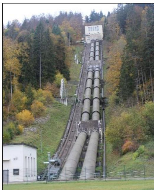
In Hüsers wurde das einfache aber geniale Prinzip der Funktionsweise eines Pumpspeicherkraftwerks zur Energiegewinnung (Turbinenbetrieb) und zur Stromspeicherung (Pumpbetrieb) anschaulich am Beispiel Schluchsee und Schwarzabecken verdeutlicht. Viele Teilnehmer waren von den Dimensionen der Hangrohrleitungen zwischen dem Schluchsee (Obersee) und dem Schwarzabecken (Untersee) beeindruckt.
